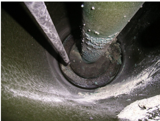
(Innenansicht eines WW-Speichers nach 8 Jahren)
