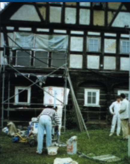
Abb 5 Substitution der Strohlehmausfachung (Quelle: TU Dresden)
